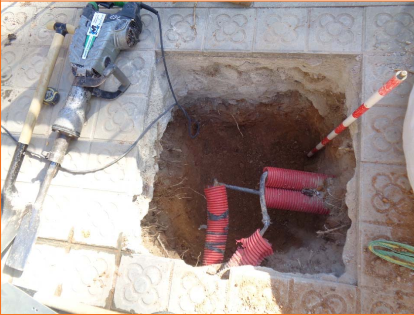
Foto 15. Vista de la Cala 8 (Fanal 7).
