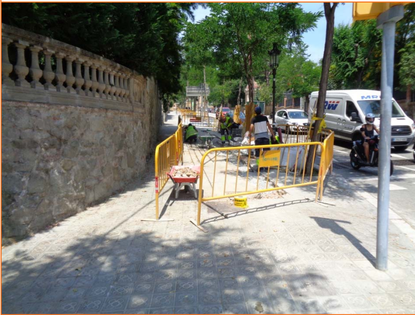
Foto 13. Vista de proximitat de la Rasa 2
