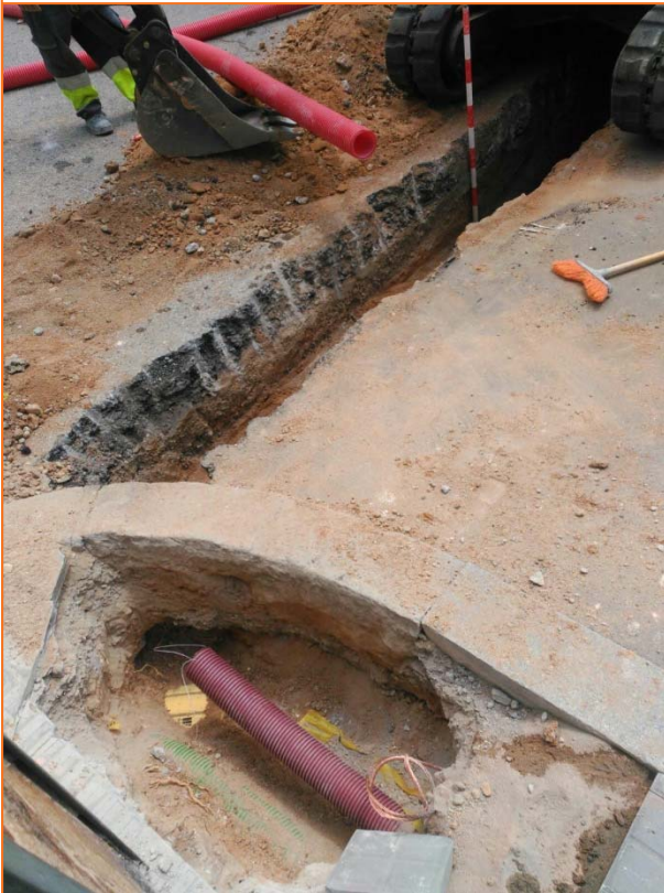
Foto 21. Vista de la Cala 10 (Arqueta 2).
